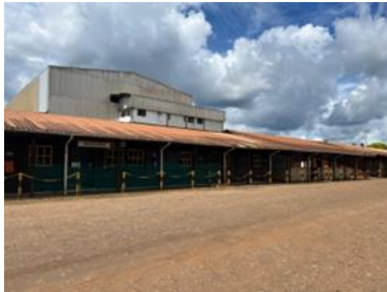
Figura 72 - Administrativo e refeitório
