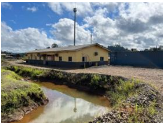
Figura 75 - Manutenção e sala de controle (1)
