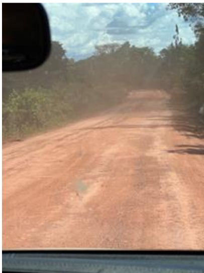
Figura 5 - Acesso à Mina (1)
