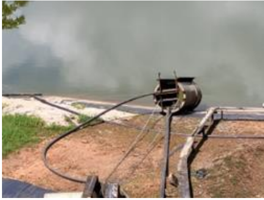
Figura 49 - Conjunto de 4 evaporadores MINETEK
