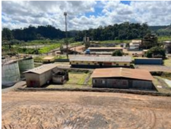
Figura 83 - 5.16. CCM Tanques de cal
