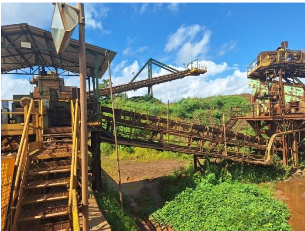
Figura 9 - Correia Transportadora CV-05
