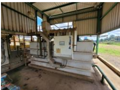
Figura 20 - Preparador de polímero PROMINENT modelo Ultromat ULFa AT 12.000
