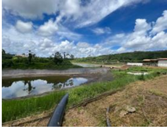
Figura 88 - Reservatório e tratamento de água Pond
