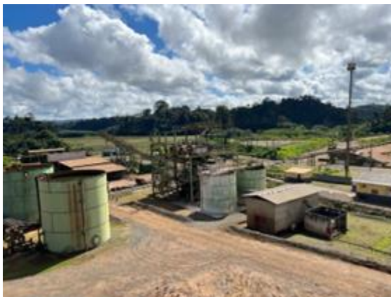
Figura 84 - Tanques de Cal- produção
