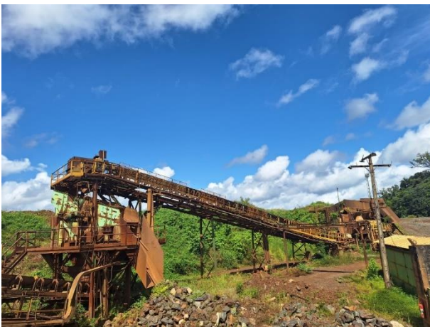
Figura 8 - Correia Transportadora CV-04
