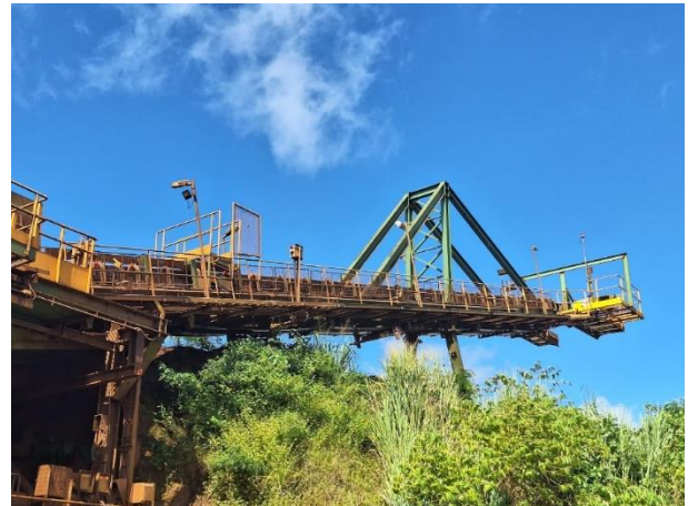
Figura 5 - Correia Transportadora CV-02
