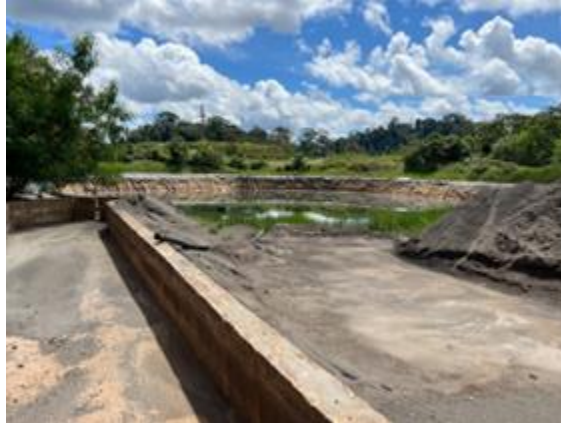
Figura 92 - Reservatório Pond contaminado CIL/DETOX
