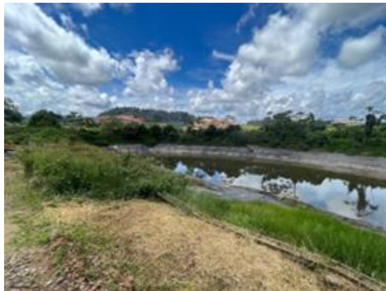
Figura 93 - Reservatório de água do processo
