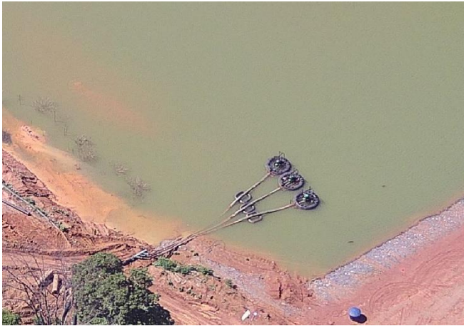
Figura 49 - Bombas Água Processo
