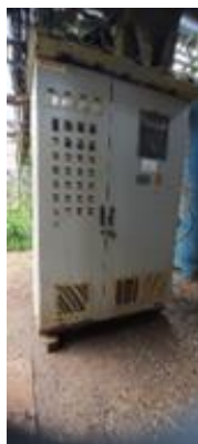
Figura 40 - Conjunto de 2 Aquecedores eletrotérmico Indutivo para aquecimento de fluido térmico BRASCOELMA
